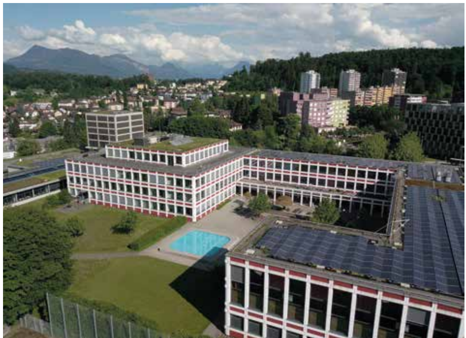
Photovoltaikanlage auf dem Dach der KSR
