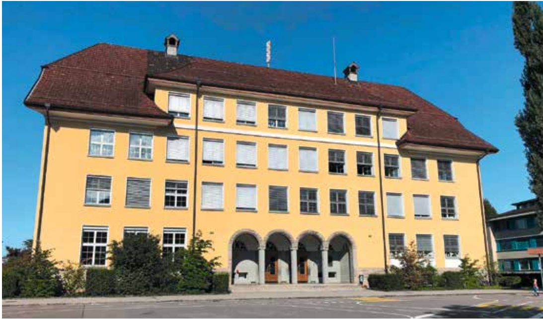
Schulhaus Littau Dorf
