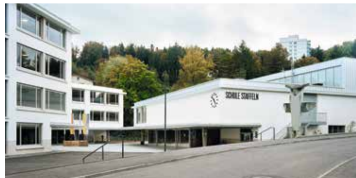
Neubau Schulanlage Staffeln
